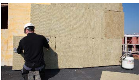
Bij het opgaand metselwerk
