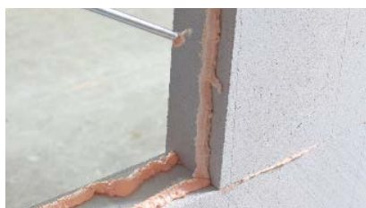
Verlijmen van cellenbeton
