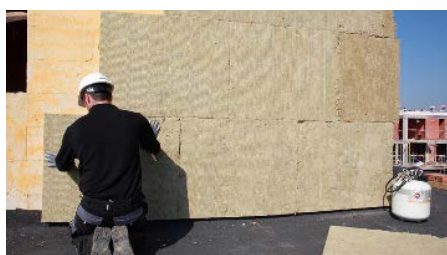
Pendant la maçonnerie en élévation
