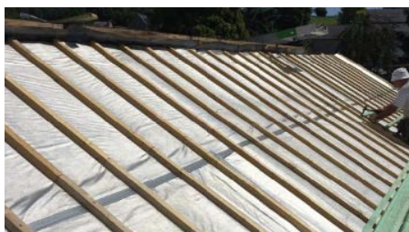
Finition de toiture : extérieur
