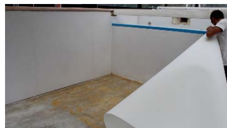
Pendant la constuction de la piscine
