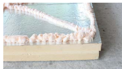
Verlijmen van isolatieplaten
