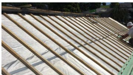
Hellend dak afwerken: buiten
