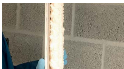
Verlijmen van gipskarton
