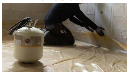
Autour le chape & plafonnage
