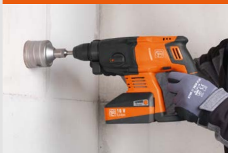
Aanbrengen van contactdoosgaten van 68 mm.
