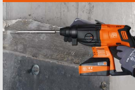
Verwijderen van uitstekende betondelen.
